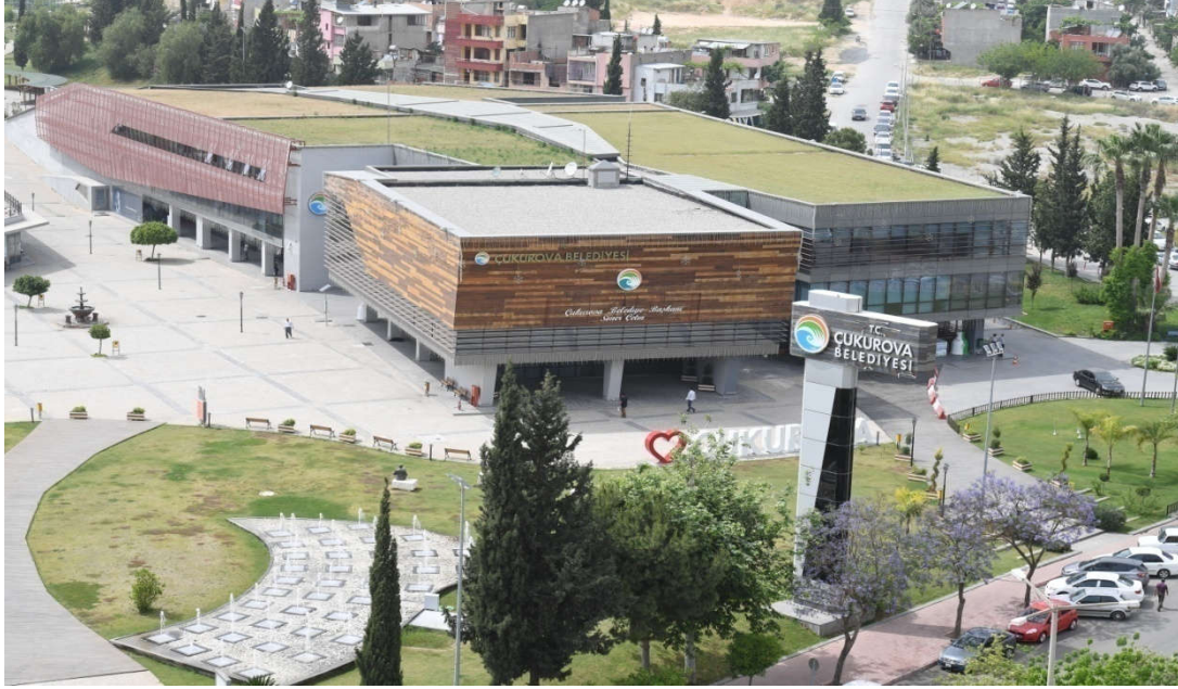
Çukurova Belediyesi Hizmet Binası
