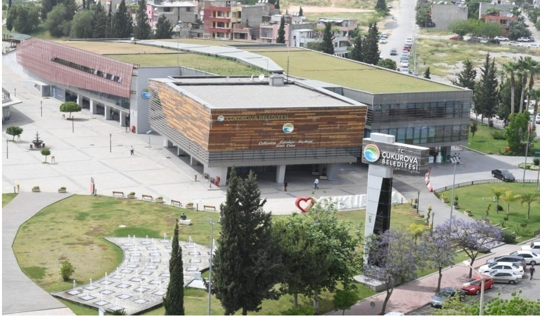
Çukurova Belediyesi Hizmet Binası
