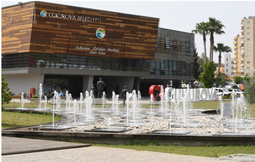
Çukurova Belediyesi Hizmet Binası
