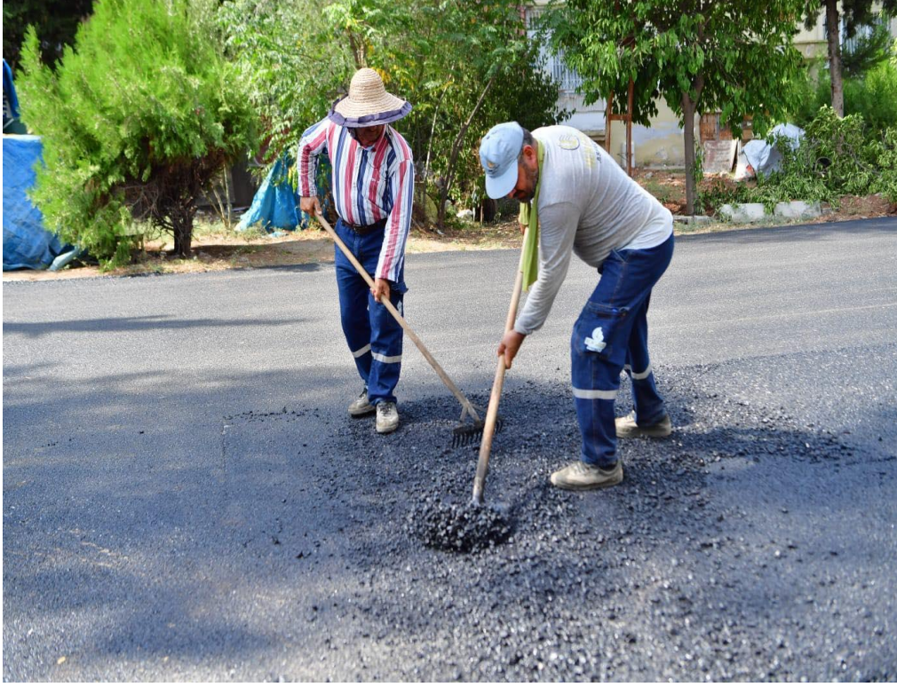
7-Mahfesiğmaz Mahallesi 79105 Sokak Asfalt Kaplama İşi;
